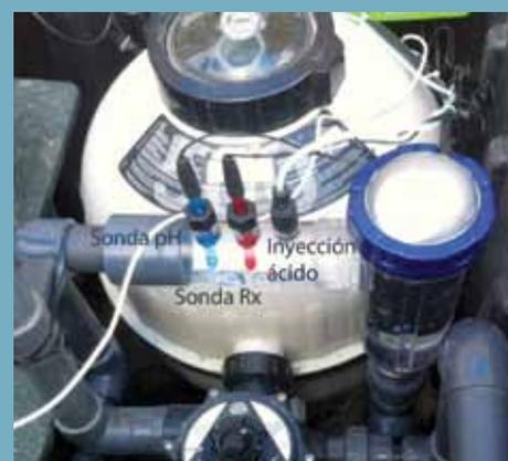
Ejemplos de instalación correcta de la sonda de pH en el sistema de filtración de una piscina privada.
